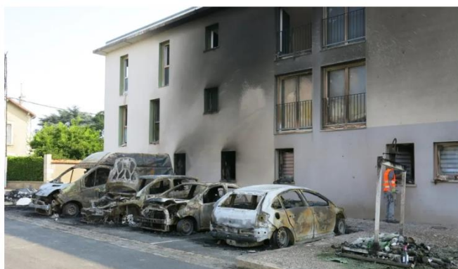
Les dégâts sont importants. Quatre véhicules brûlés et des appartements endommagés. © (Photo NR Marie-Laure Aveline)
