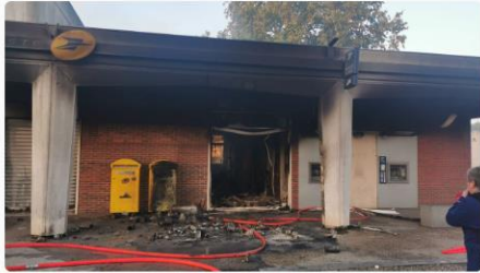
La Poste des Couronneries incendiée cette nuit. © Radio France - Théo Caubet
