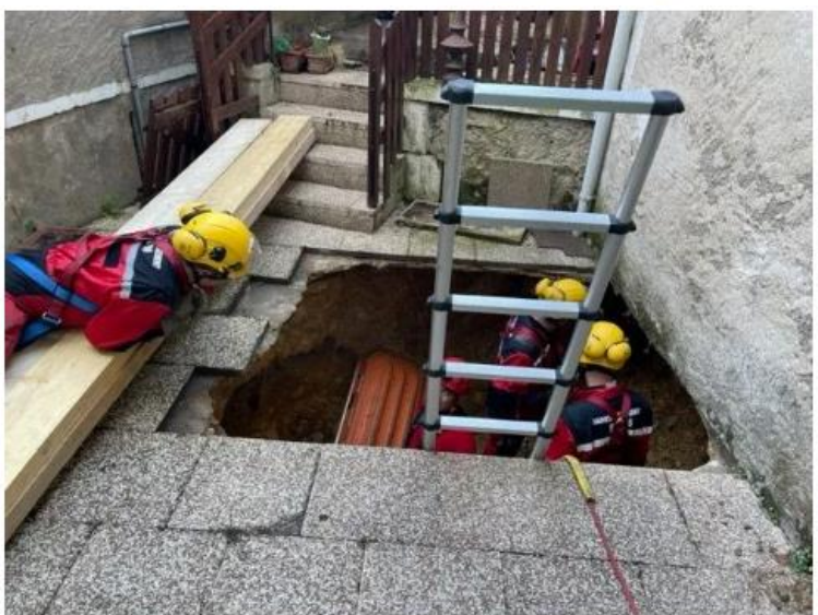
Ce mercredi à Montmorillon, un homme de 81 ans a fait une chute de 3 mètres après l'effondrement de sa terrasse. --
