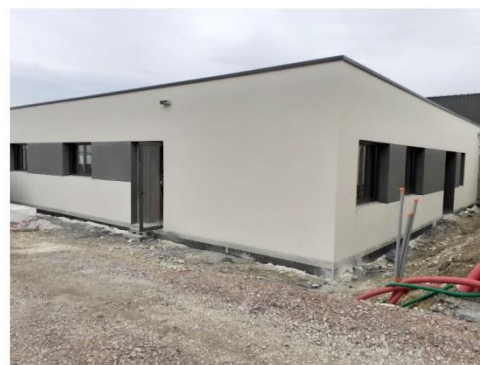
Enduits extérieurs terminés
